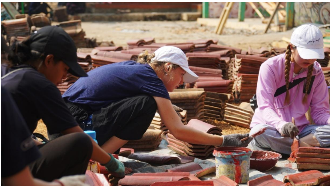
Gambar 4.12. Pengecatan Genting Balai Dusun Kesiman
