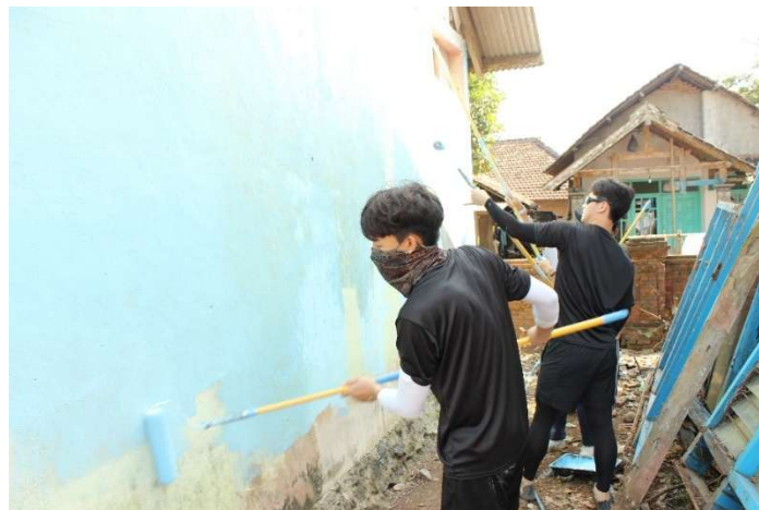
Gambar 3.8 Pengecatan dinding SD Petung
